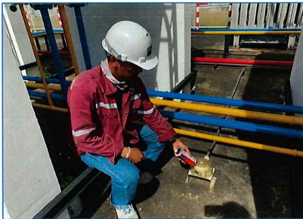
รูปการทดสอบระบบ GAS LEAK DETECTOR
